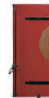
Volet à lames verticales penture & contre-penture
